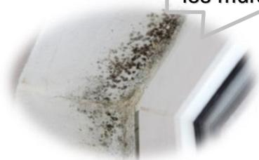
Dans une construction mal isolée, la surface des murs extérieurs est beaucoup plus froide que l'air ambiant.
