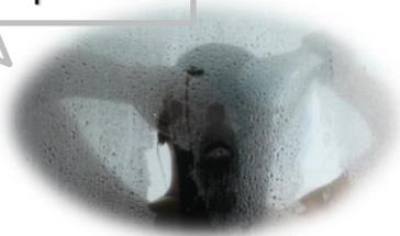
Les zones de condensation apparaissent principalement dans les locaux humides. La condensation se manifeste par l'apparition de taches grises constituées de poussière collée, de moisissures, ou la présence de mauvaises odeurs, des décollements de tapisseries peuvent avoir la même origine.
